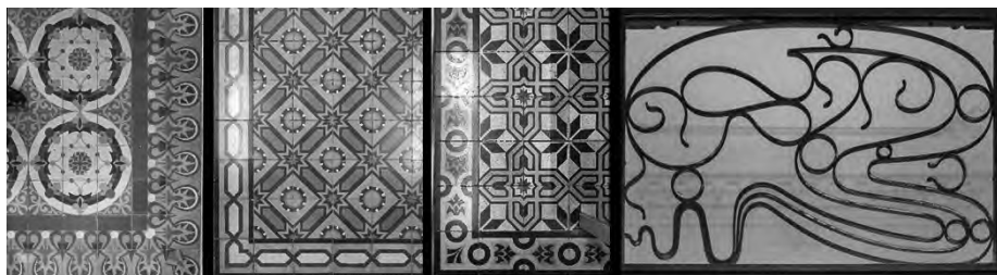
Figura 12. Modelos de baldosas hidráulicas recuperados en el edificio, el primero de ellos es el más caro y complejo del catálogo de José Botí; y detalle de la singular cerrajería modernista de la puerta del vestíbulo de entrada.
