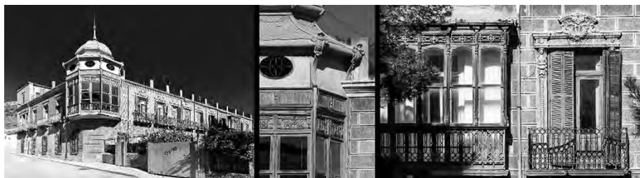
Figura 25. Vistas del exterior de la casa del Tío Lobo. Vista de la esquina suroeste, detalle del mirador de esquina y vista de la fachada principal donde se aprecia el mirador cartagenero y uno de los balcones.
