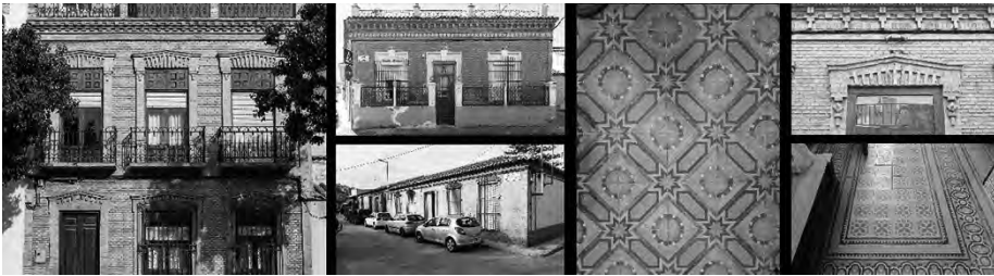
Figura 3. Ejemplos de vivienda popular de interés, con detalles arquitectónicos y ejemplos de pavimentos hidráulicos existentes en estas viviendas.
