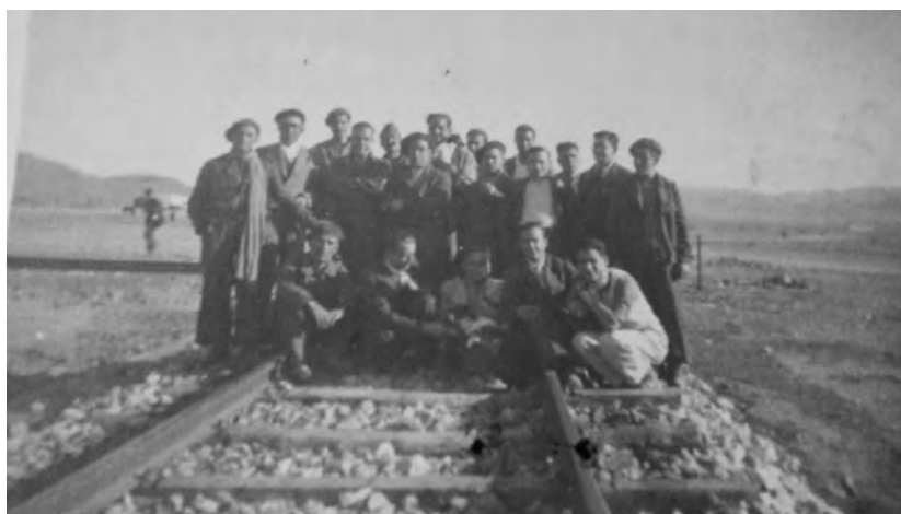
Exiliados españoles en el campo de Bou Arfa trabajando en la construcción del ferrocarril Subsahariano. Fotografía cedida por la familia Cazorla Cazorla.
