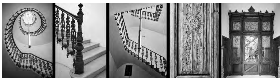
Figura 11. Vistas del interior del edificio en la actualidad donde se pueden apreciar las dos escaleras existentes, las puertas de las antiguas viviendas y la segunda puerta de acceso al edificio.
