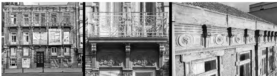
Figura 6. Imágenes del exterior de la Casa Celestino, con detalles en piedra artificial.
