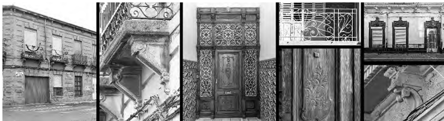
Figura 33. Imágenes de los siguientes edificios y viviendas: Las dos primeras pertenecen a las viviendas de la calle Mar Menor; el segundo grupo pertenecen al edificio de calle Mayor 53, con el acceso al portal y detalles modernistas en rejería de balcones y puerta de acceso. El último grupo pertenecen a la vivienda de calle Tetuán 22, con detalles de la ménsula modernista en una de las imágenes.
